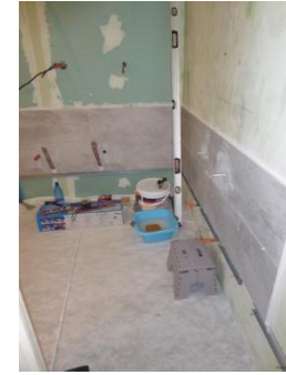
Retrait baignoire & vasque, pose rails & placo de doublage, électricité, pose couche d'étanchéité baignoire et receveur de douche
