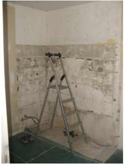
Retrait baignoire & vasque, pose rails & placo de doublage, électricité, pose couche d'étanchéité baignoire et receveur de douche
