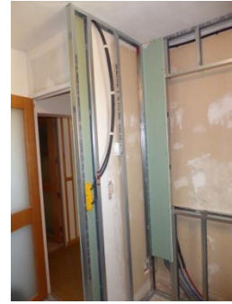
Retrait baignoire & vasque, pose rails & placo de doublage, électricité, pose couche d'étanchéité baignoire et receveur de douche
