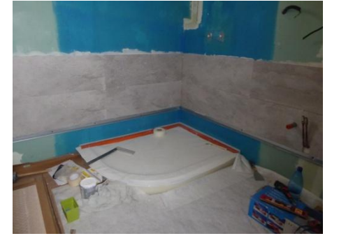
Retrait baignoire & vasque, pose rails & placo de doublage, électricité, pose couche d'étanchéité baignoire et receveur de douche
