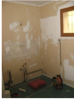
Retrait baignoire & vasque, pose rails & placo de doublage, électricité, pose couche d'étanchéité baignoire et receveur de douche
