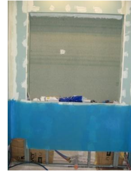
Retrait baignoire & vasque, pose rails & placo de doublage, électricité, pose couche d'étanchéité baignoire et receveur de douche
