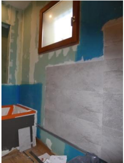
Couche d'étanchéité & pose faïence, préparation insertion 2 ème miroir
