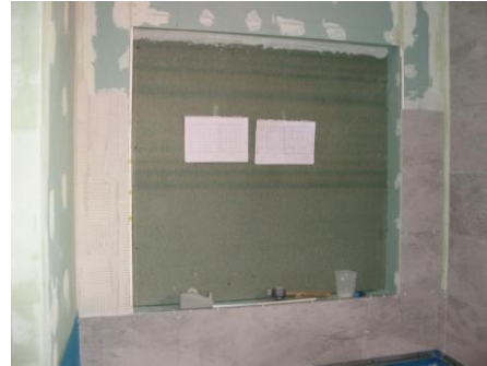
Couche d'étanchéité & pose faïence, préparation insertion 2 ème miroir
