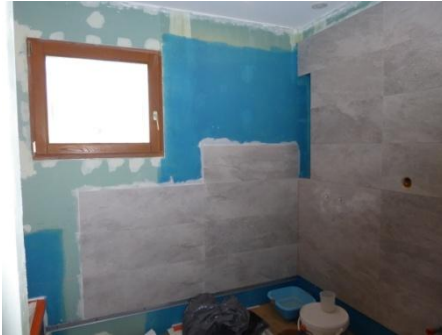
Couche d'étanchéité & pose faïence, préparation insertion 2 ème miroir
